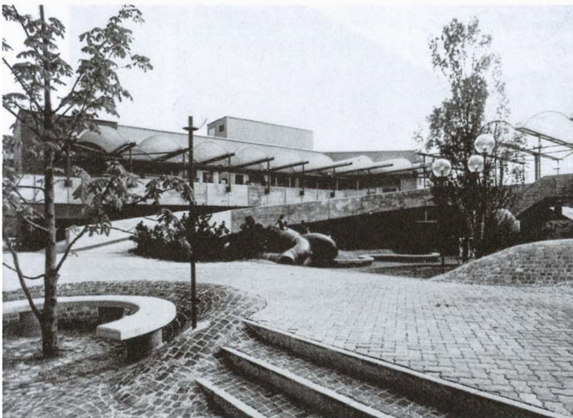
Das alte Quartierzentrum: Abbildung von 1974 aus der «Schweizerischen Bauzeitung».
