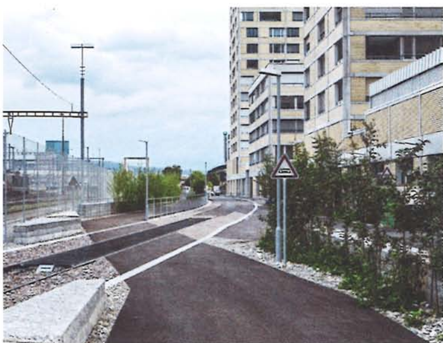
Viel Verkehr auf wenig Raum: Fuss- und Radweg, Bahntrasse und Erschliessungsstrasse durchqueren den schmalen Aussenraum entlang der Gleise.
