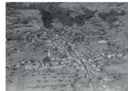
Kaltbrunn mit der Seilbahn, Luftbild 1:500
